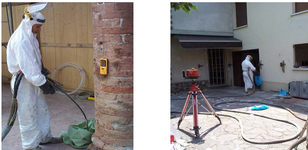
Fig. 2 - Fase lavorativa – Iniezione e monitoraggio
