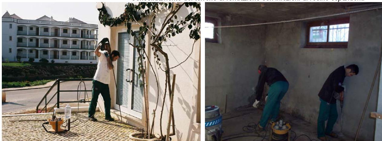
Fig. 1 - Fase lavorativa – Foratura
